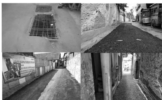
Gambar 3. Drainase, dan Jalan Lingkungan
