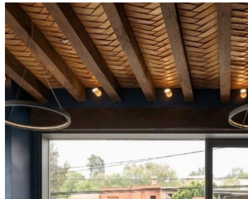
Gambar 4. Aplikasi Rotan Laminasi pada langit-langit
