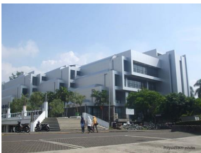
Gambar 10. Fasad Perpustakaan ITB Sumber:
