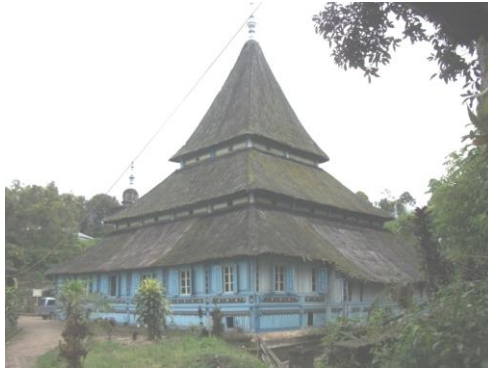
Gambar 2 : Masjid Bingkudu – Minangkabau
