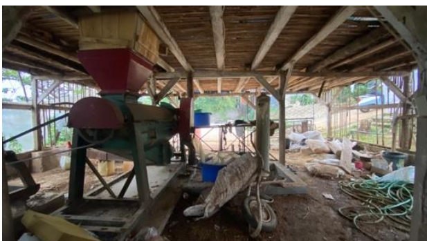
Gambar 4. Area pengolahan di dalam shelter kopi (bagian 2) Sumber : Koleksi Peneliti, 2023
