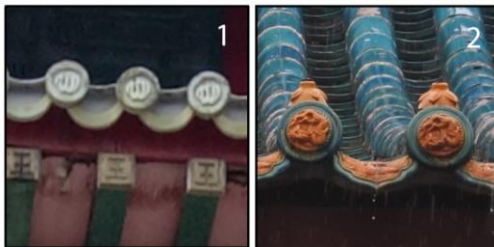
Gambar 7. Penutup Atap Sumber : Data Pribadi, 2017
