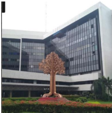
Gambar 1. Fasad Gedung Bina Graha KLHK (Sumber: Penulis, 2023)
