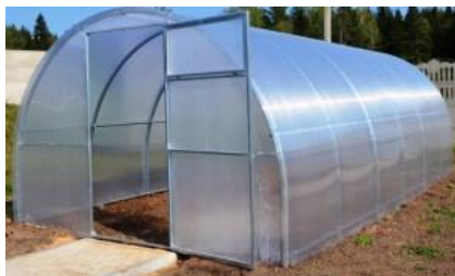
Gambar 1. Kontruksi greenhouse tipe tunnel .
