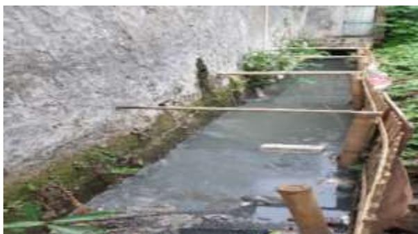
**Gambar 4.** Kondisi drainase yang mengalami penyempitan
