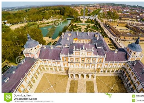
5a Bangunan lapas dari atas Sumber: [25]
