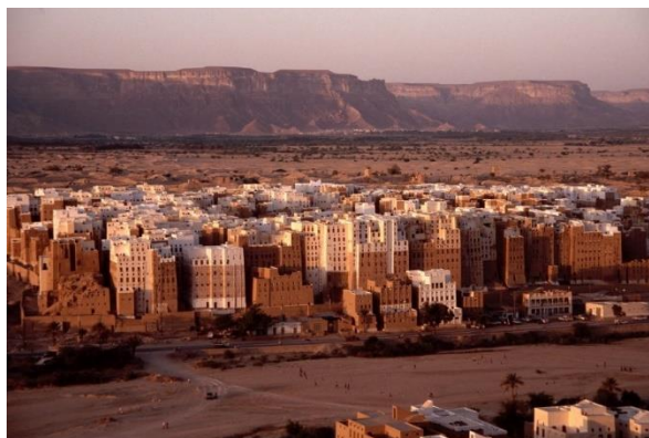
Gambar 3. Gurun Manhattan, Gedung tertinggi pertama di dunia [16]
