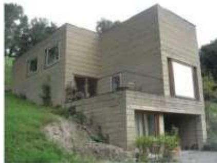
Gambar 1. Rauch House, Rumah berjumlah 3 lantai yang menggunakan konstruksi RE tidak stabil [10]
