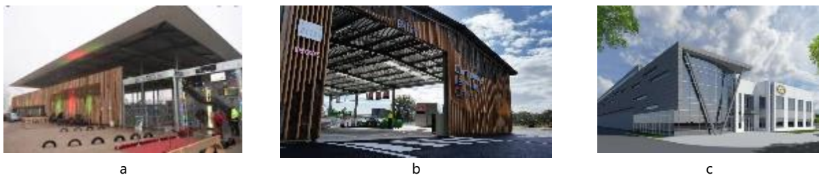
Gambar 15. Tampak Luar Bangunan Manajemen Sampah
