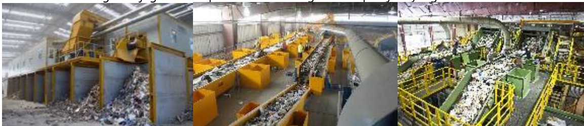
Gambar 5. Bangunan Pengolahan Limbah Bekas Konstruksi
