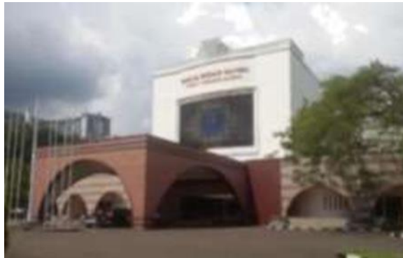
Gambar 6. Kondisi fasad sasana budaya ganesha
