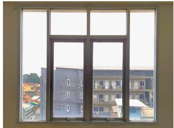
Gambar 7 Jendela Ayun Engsel Ambang Atas Perpustakaan UNIKOM Sumber: Dokumen Pribadi, 2023
