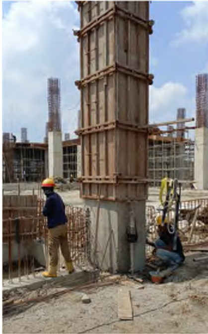
Gambar 3. Bekisting Kolom (Sumber: Dokumentasi Proyek BOP)
