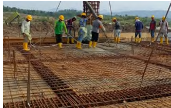
Gambar 5. Bekisting Pelat (Sumber: Dokumentasi Proyek BOP)
