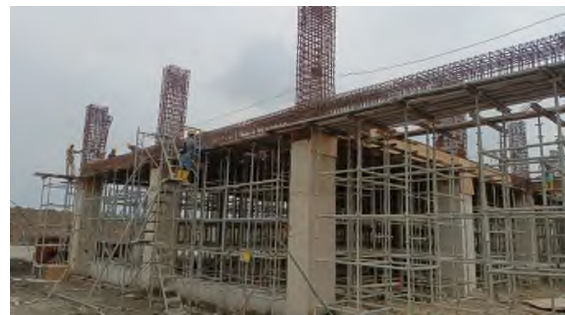
Gambar 4. Bekisting balok dengan bentang bersih 8 m, diantaranya ditopang penopang ( propping ) berjarak 2 m (Sumber: Dokumentasi Proyek BOP)
