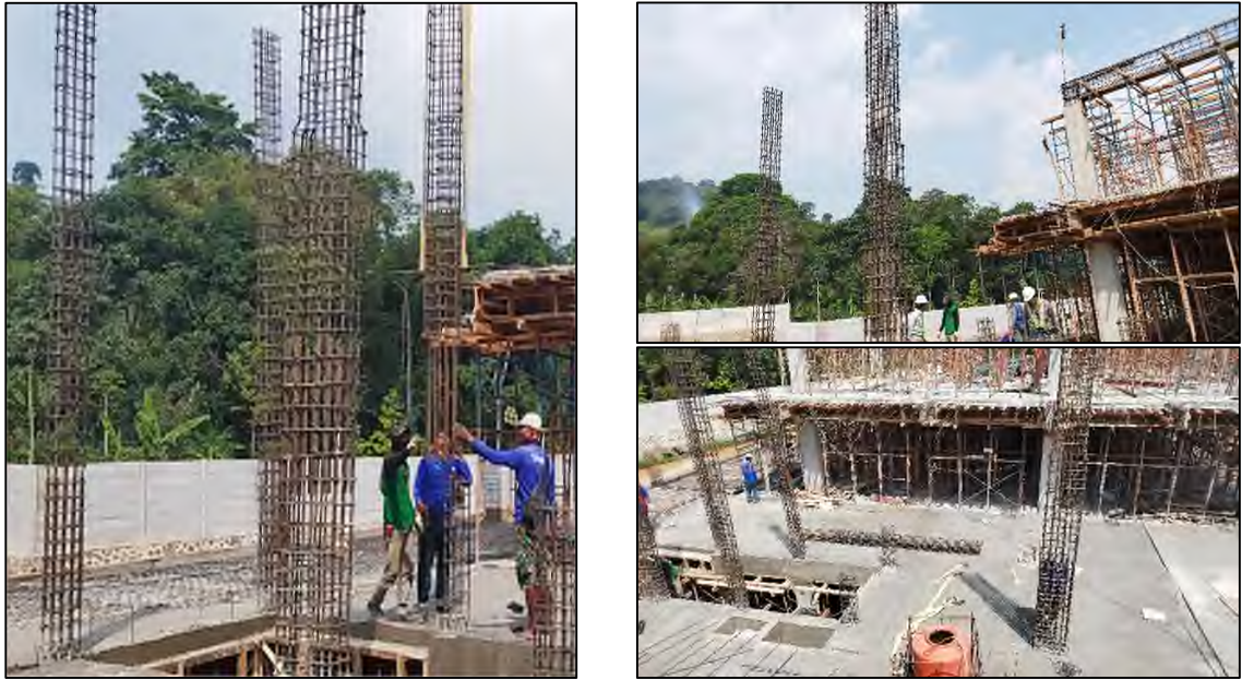
Gambar 1. Konstruksi Pembuatan Kolom
