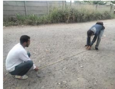
Gambar 7 Kerusakan Pelepasan Butiran
